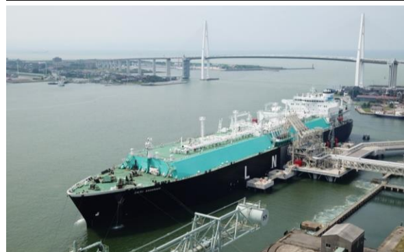
図2 LNG船の荷役状況
