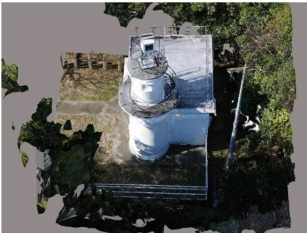
図 3 3D モデルの例(鳥羽導灯(後灯))
