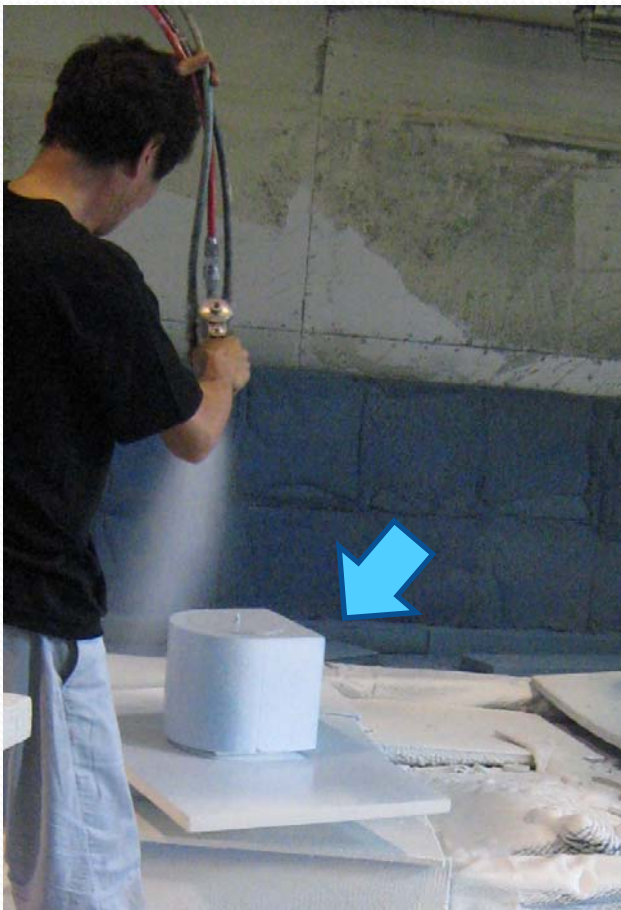
エフレタン吹き付け塗装の様子
