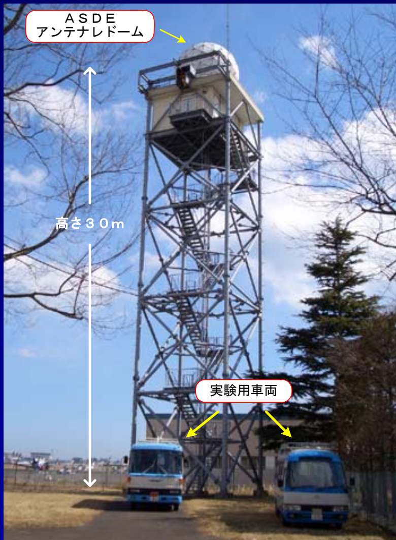
◆ASDEアンテナ鉄塔
