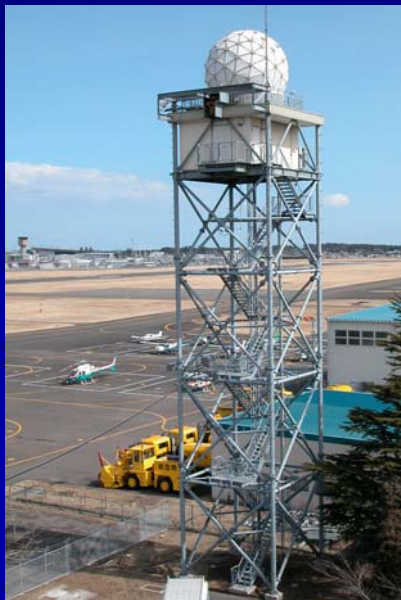
◆ASDEアンテナ鉄塔
